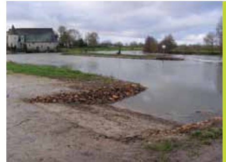
La cale de mise à l'eau fraîchement installée en amont du moulin.
